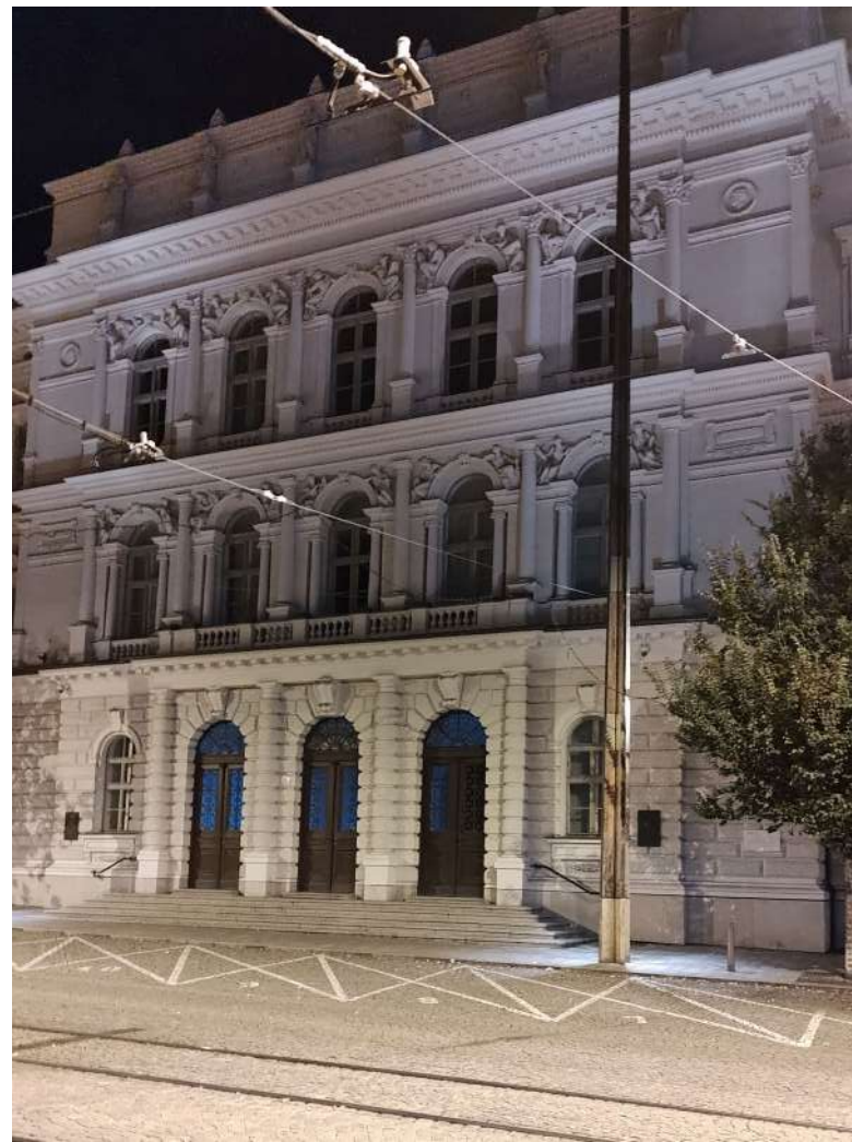
Večerní budova Ústavního soudu [1]
